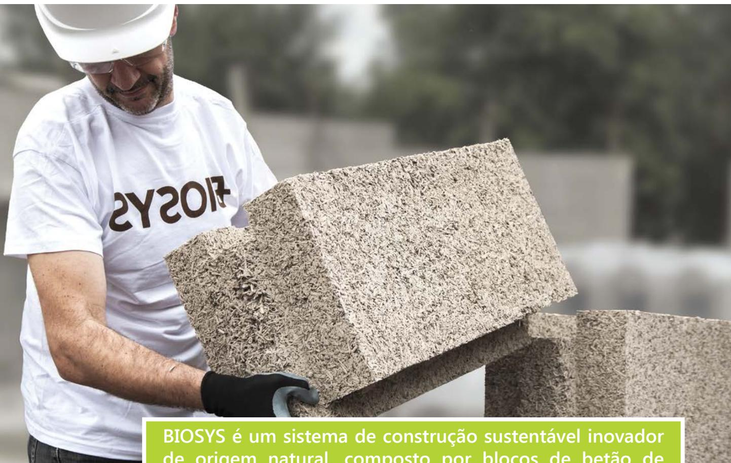
BIOSYS é um sistema de construção sustentável inovador de origem natural, composto por blocos de betão de cânhamo que se montam por encaixe a seco (sem cola e sem argamassa).
